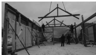
Einbau Dachgebälk
