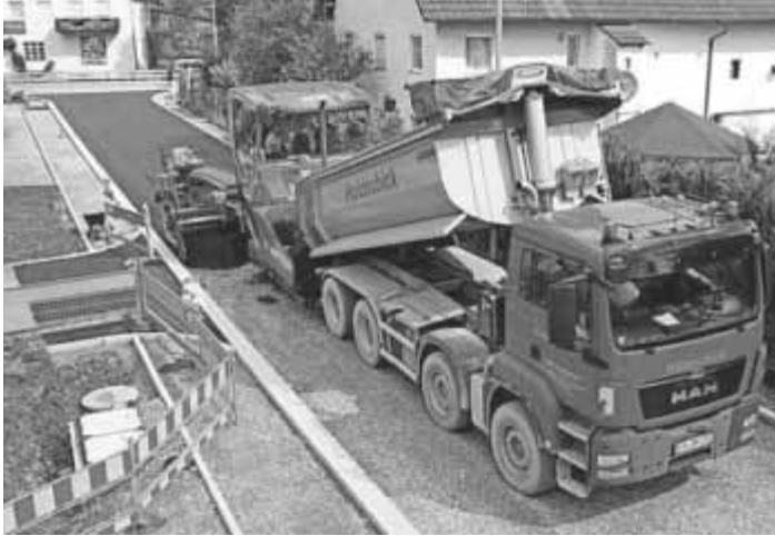
Asphaltierarbeiten in der Zeppelinstraße
