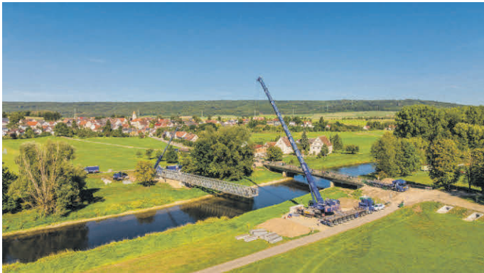
Die Behelfsbrücke über die Donau bei Daugendorf wurde mit einem Kran eingehoben.
