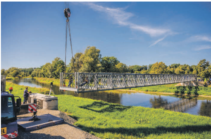
Ehrenamtliche des Technischen Hilfswerks haben am Wochenende die Behelfsbrücke errichtet.
