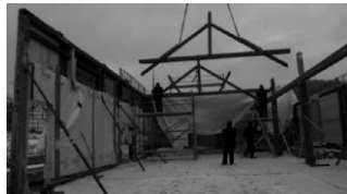
Einbau Dachgebälk
